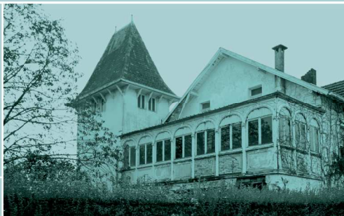
Savonnerie, ancien logement patronal
